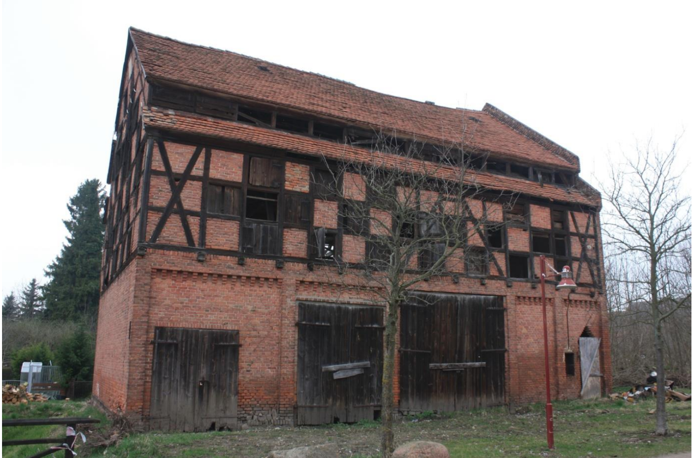
Widok na budynek, rok 2017
