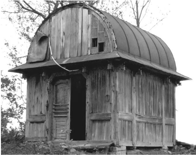
Fot. 2. Sklepik w trakcie przygotowań do translokacji. Kolonia Stężycza 2005 r.
